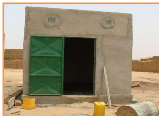
Magasin de type II construit au bénéfice de la BI de Yanta (Filingué) pour la production de mil et sorgho
