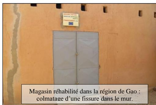
Magasin réhabilité dans la région de Gao : colmatage d'une fissure dans le mur.
